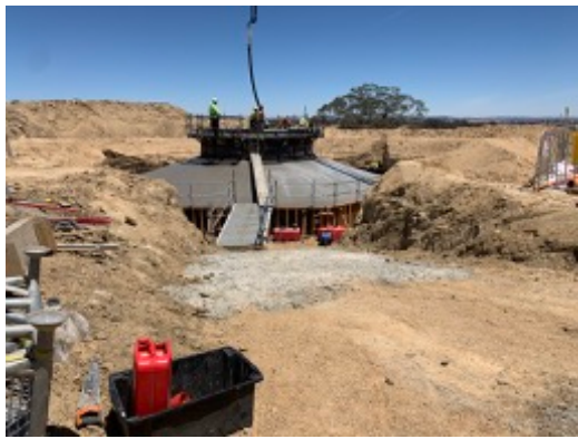
Photo 39: Wind turbine foundation pour at WTG 11..
