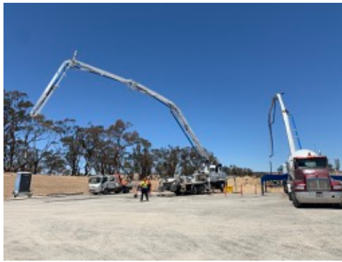
Photo 38: Wind turbine foundation pour at WTG 11.
